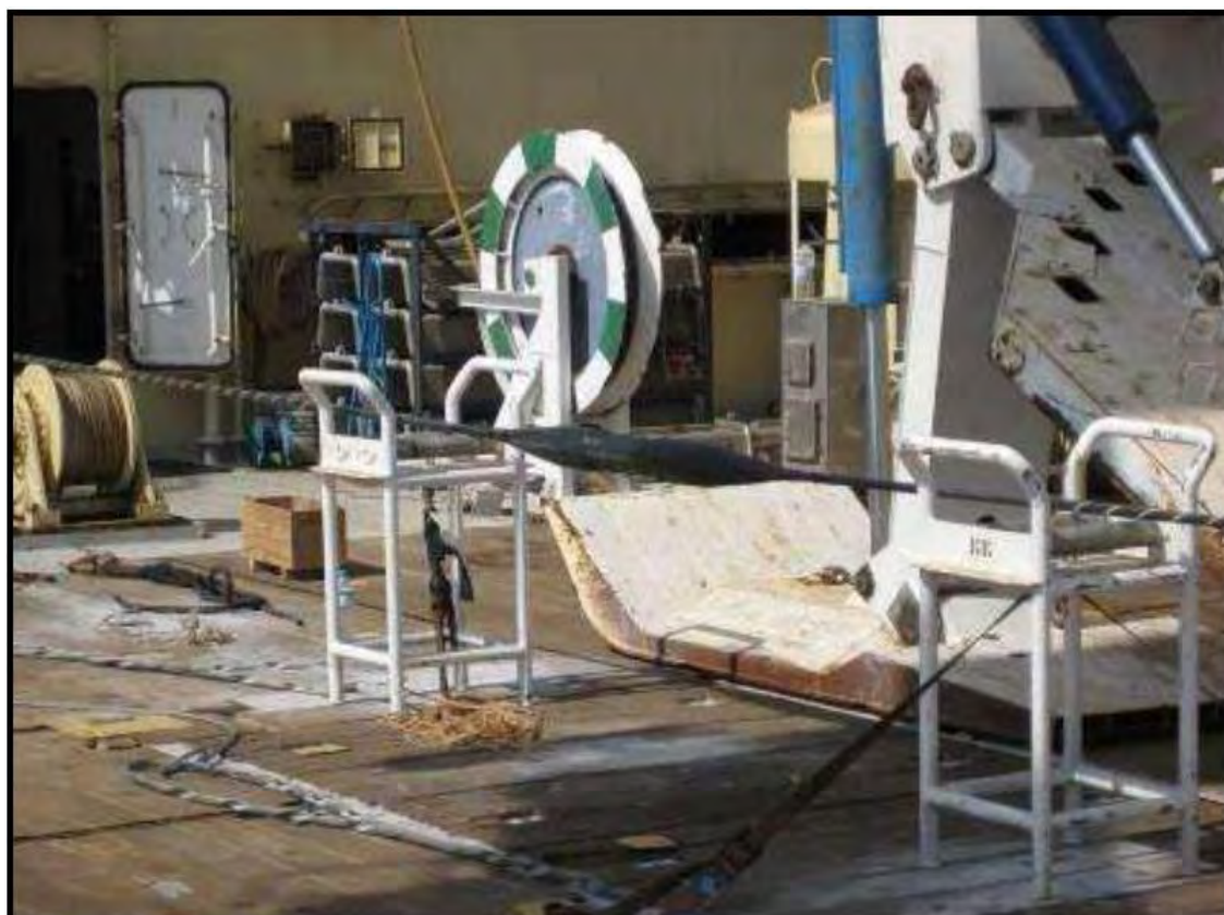
Figura 15 – Exemplo de junção do cabo submarino, realizada a bordo do navio de instalação
