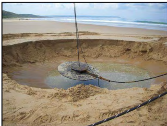
Foto 4 – Exemplo de implantação da placa de aterramento
