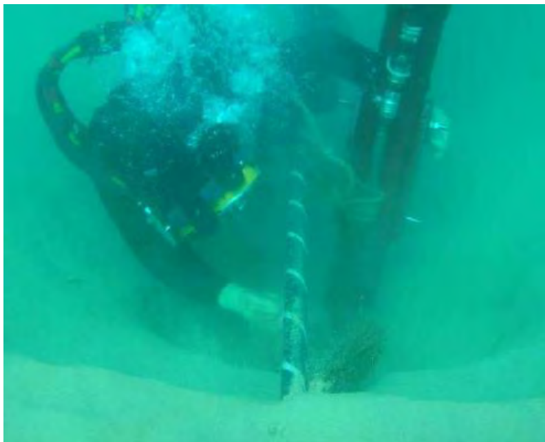
Foto 2 – Mergulhador utilizando ferramenta de jateamento manual
